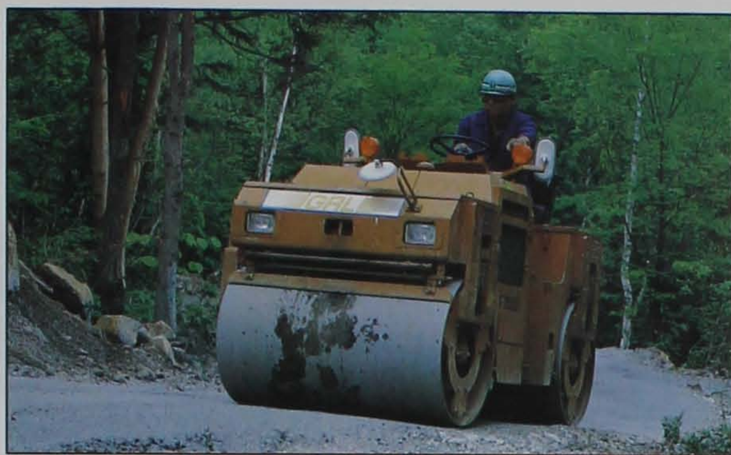
Вибрационный каток делает прочной поверхность новой дороги.
