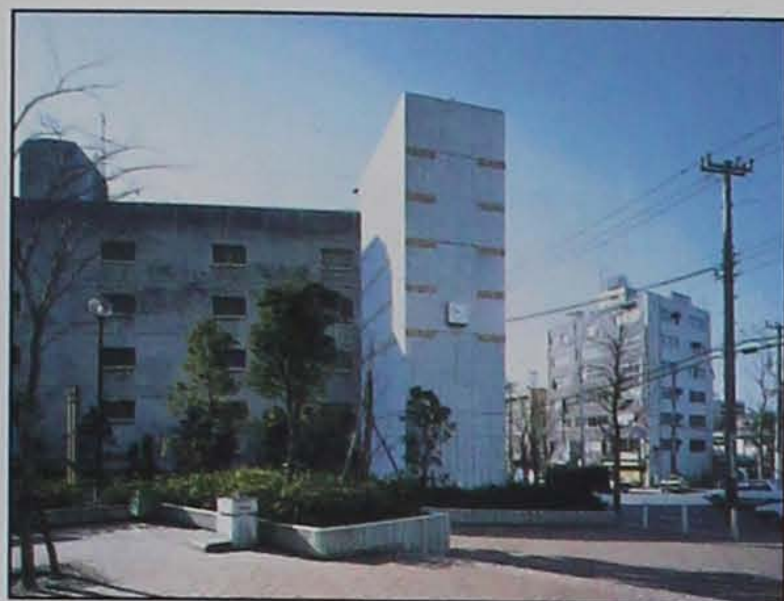
Воздухозаборник вентиляционного канала. Один из них замаскирован под архитектурное украшение.
