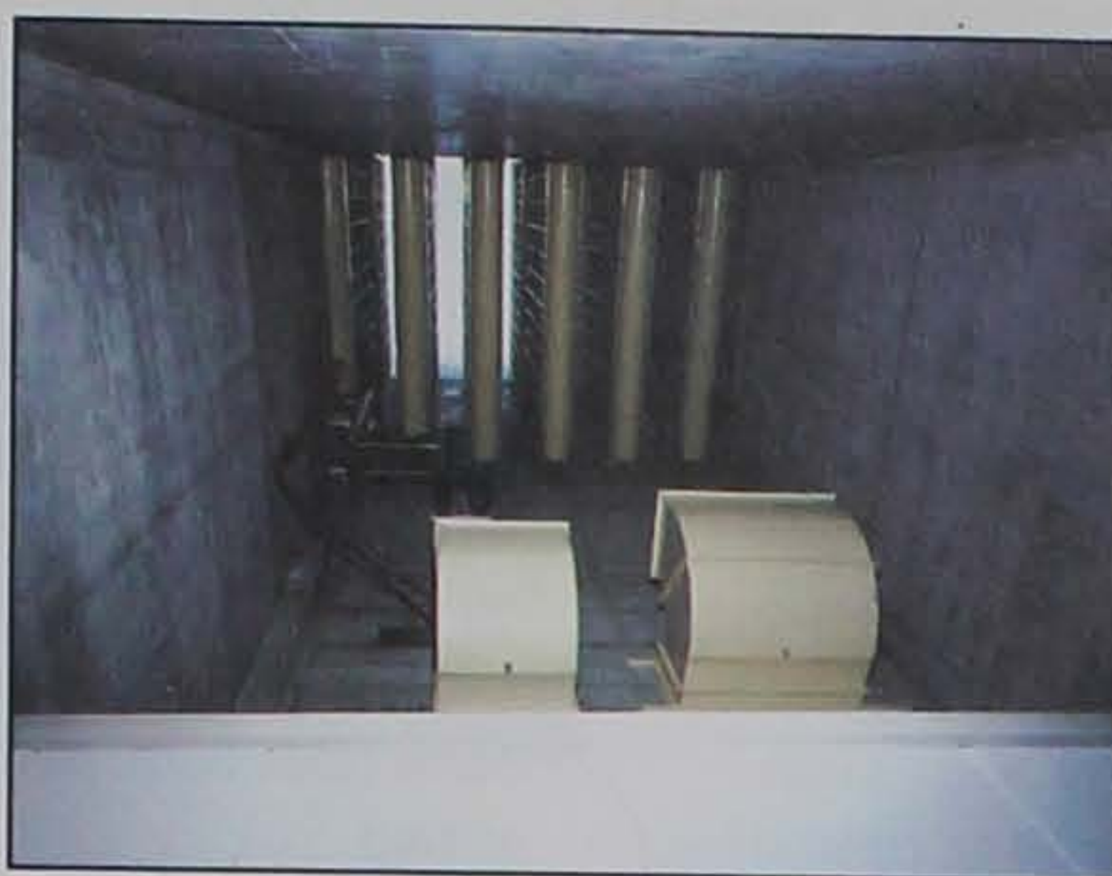
Шумопоглощающая система. Стены вентиляционного канала с внутренним покрытием поглощают шум от работы вентиляторов.
