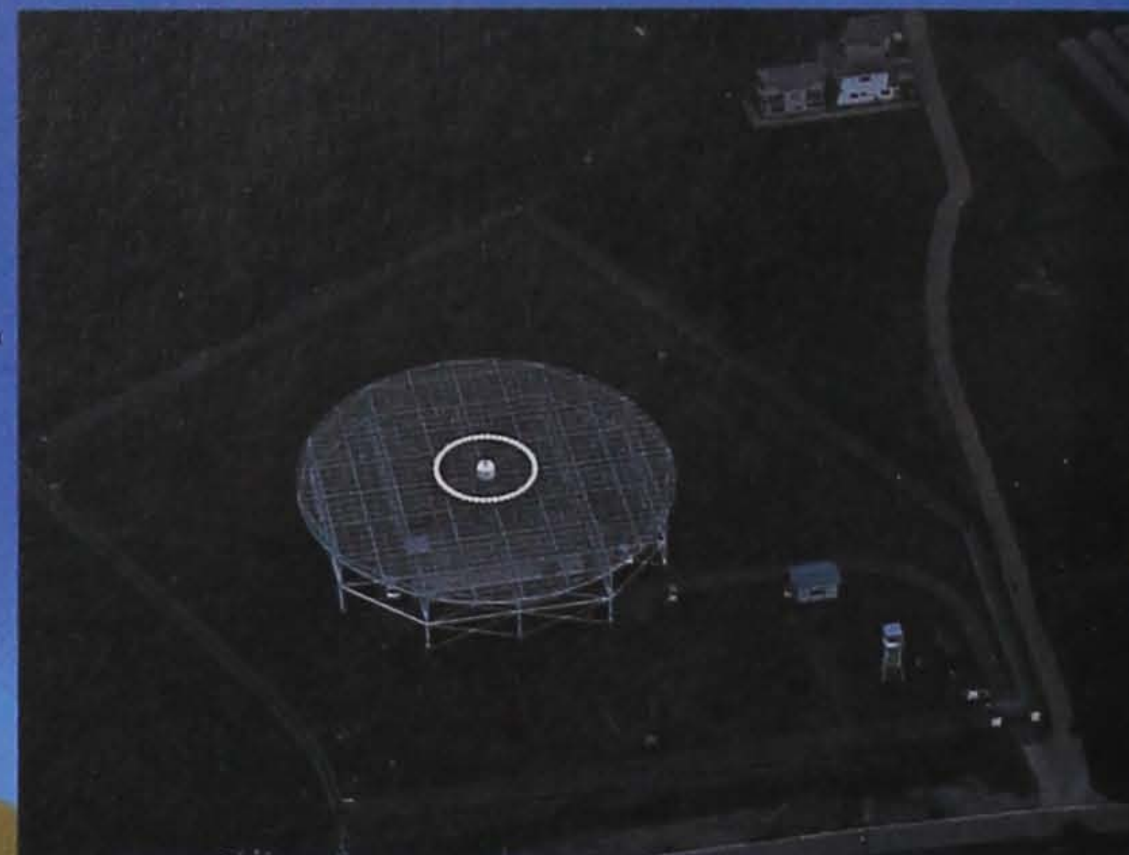
ВКР станция излучает радиоволну, принимая которую штурманы могут определять свои координаты.
