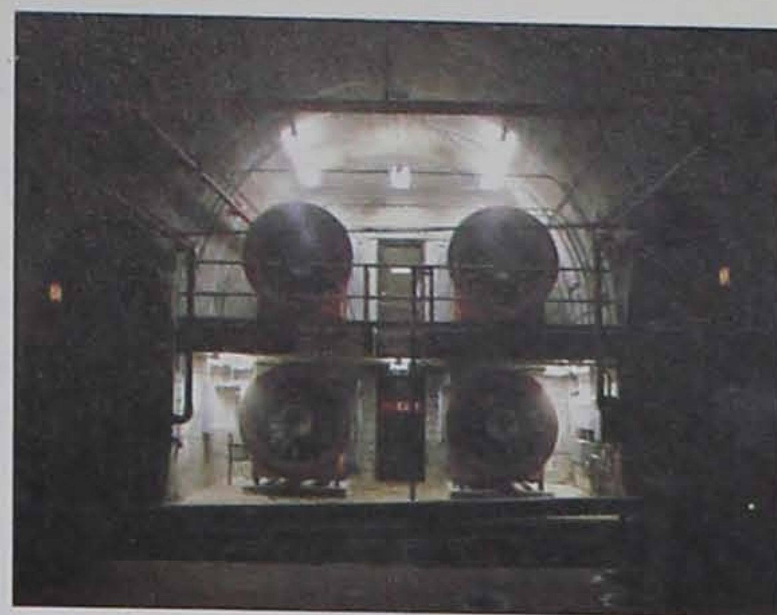
Вентиляторы выпускного канала. Несколько огромных вентиляторов проветривают станцию метро.
